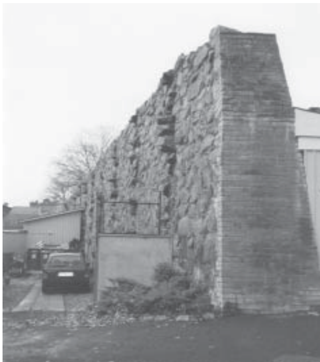
Sträckningsmuren bakom Sjöofficersmässan
